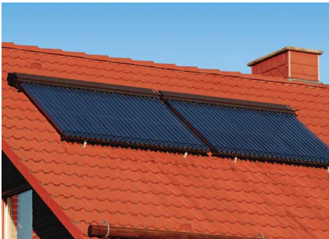
Vakuüm-Röhren- kollektor nach dem Heatpipe-Prinzip
